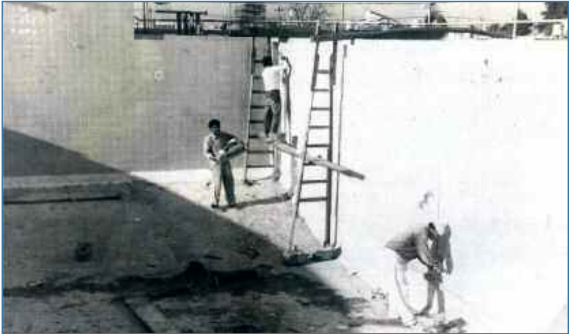
Construcción de la pileta de natación del Campo de Deportes de Ramos Mejía
